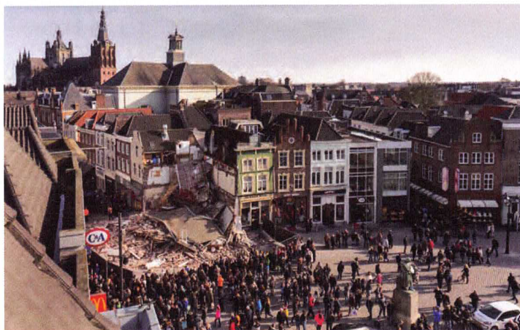
Foto uit 2016, nadat een interieurbouwer tijdens werkzaamheden een dragende balk weghaalde. Daardoor stortte het pand volledig in.
